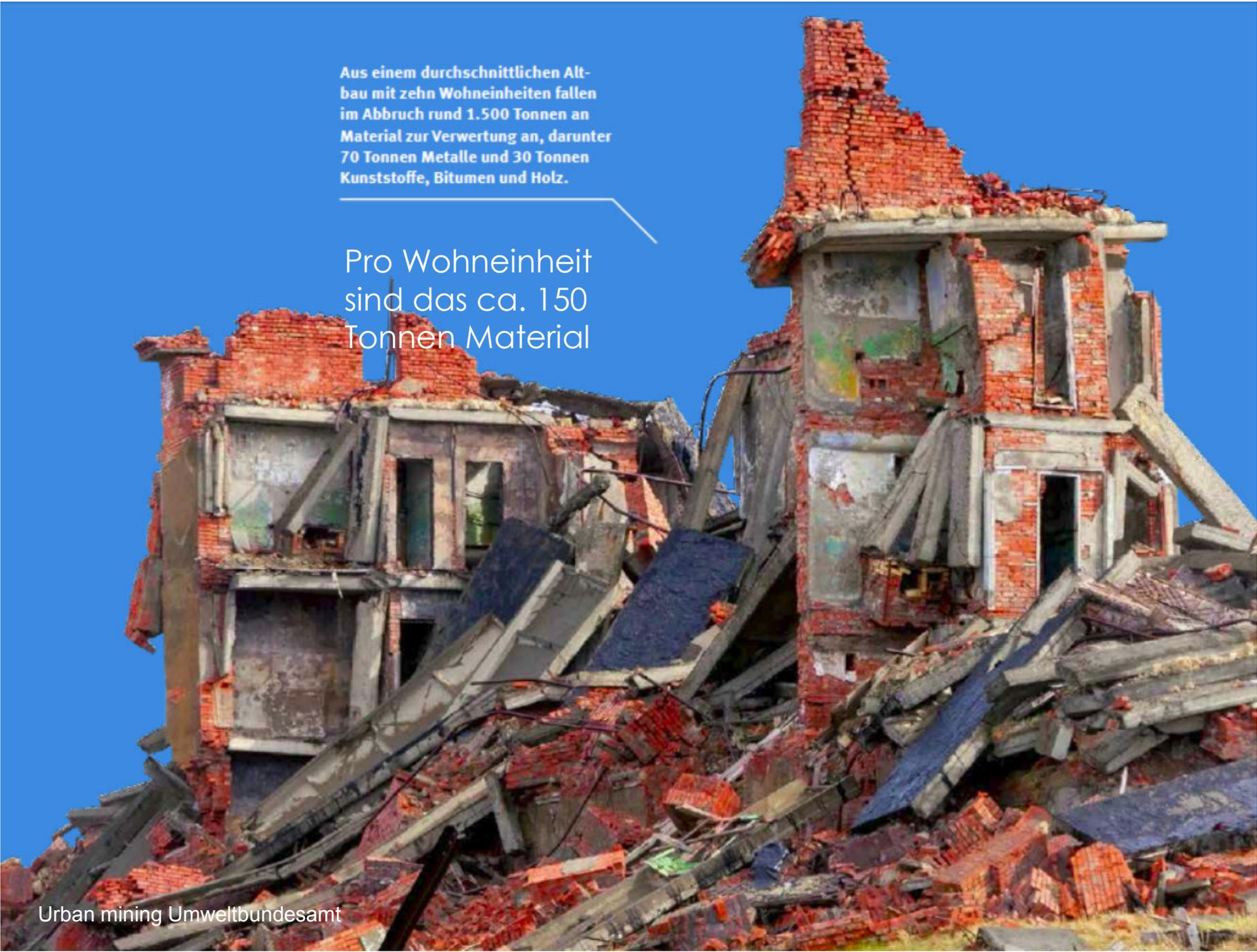
Aus einem durchschnittlichen Altbau mit zehn Wohneinheiten fallen im Abbruch rund 1.500 Tonnen an Material zur Verwertung an, darunter 70 Tonnen Metalle und 30 Tonnen Kunststoffe, Bitumen und Holz.
