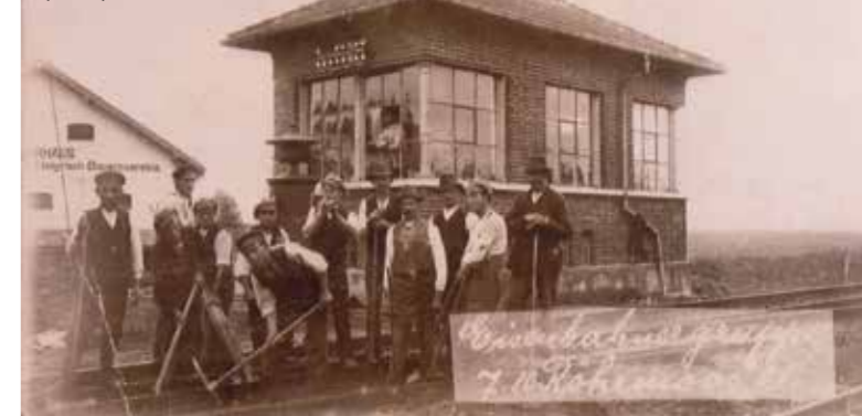
Das Stellwerk „Turm“ bei der Baywa in Röhrmoos mit dem Großvater des Autors Johann Thaler (2.v.r.)
