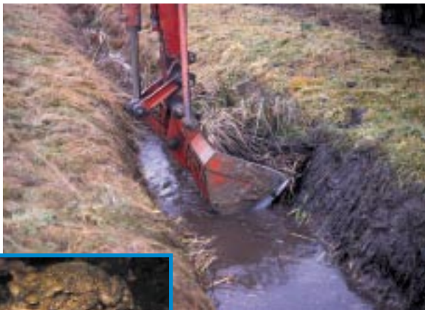
Grabenräumung mit Bagger
