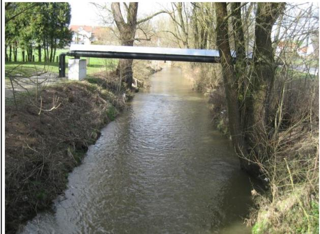
Abbildung 7: Fernwärme-Leitung Bulachgraben (OW Brücke St. Vitus-Straße)
