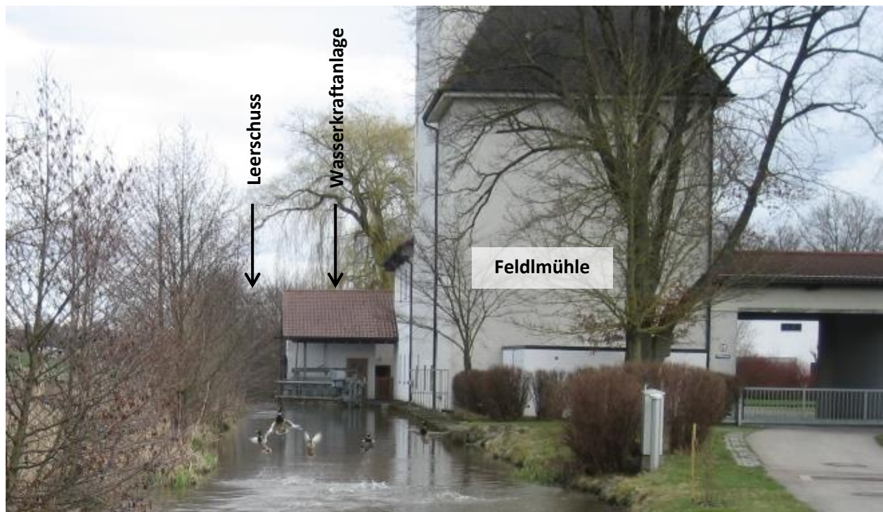
Abbildung 17: Feldmühle mit Wasserkraftanlage
