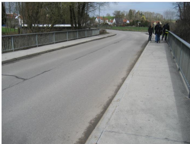
Abbildung 7: Brücke St. Vitus-Straße über Bulachgraben
