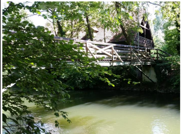
Abbildung 12: Fußgängerbrücke am Amperkanal
