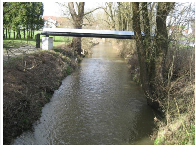
Abbildung 8: Fernwärme-Leitung Bulachgraben (OW Brücke St. Vitus-Straße)
