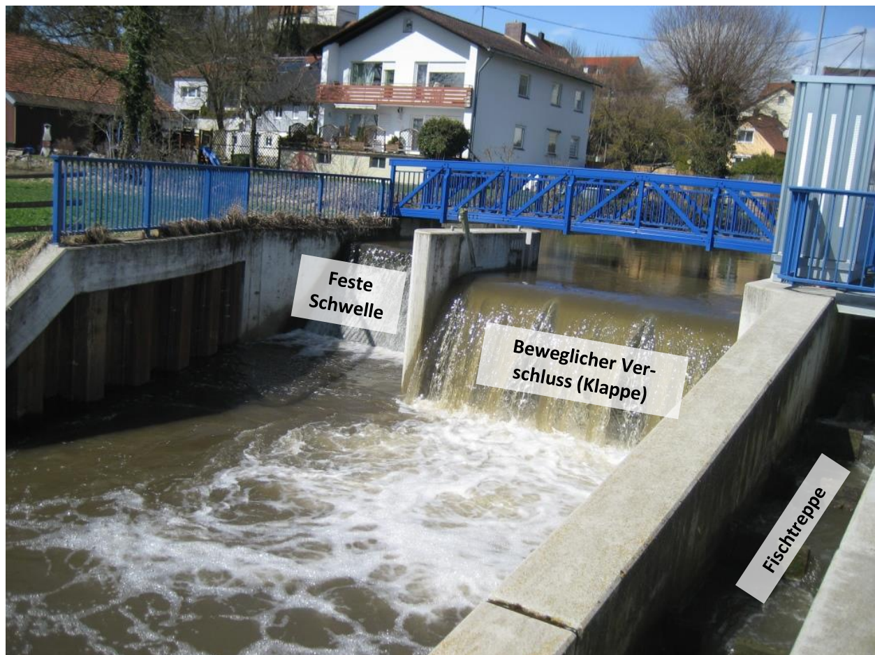
Abbildung 16: Ausleitungswehr am Beginn des Bulachgrabens
