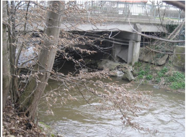
Abbildung 10: Brücke Staatsstraße – Auslauf (UW)
