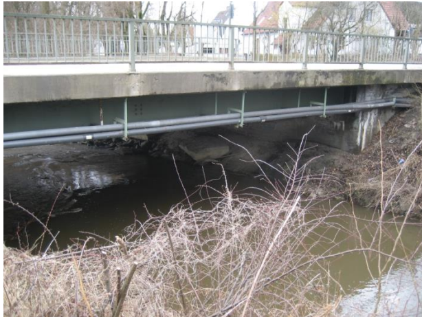
Abbildung 9: Brücke Staatsstraße – Einlauf (OW)
