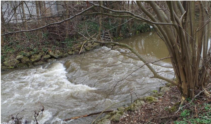
Abbildung 13: Sohlschwelle im Bulachgraben (bei Anwesen Brucker Straße 6a)
